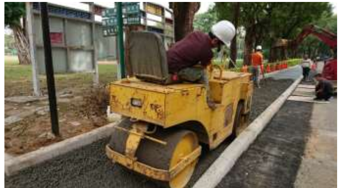
熾陽大道人行步道 107 年施工中
