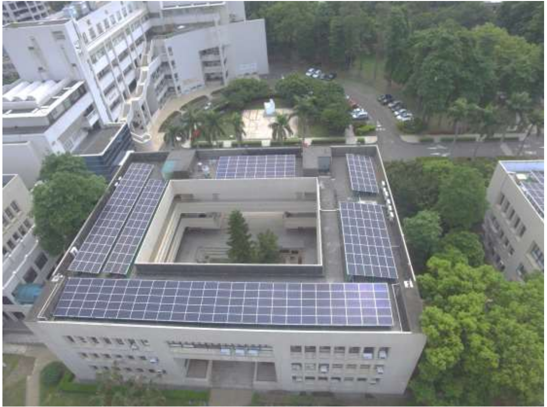
圖二 106 年行政大樓屋頂設置太陽能版
