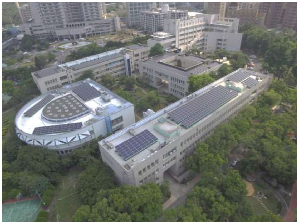
圖三 106 年中庭周邊 4 棟建物屋頂設置太陽能版
